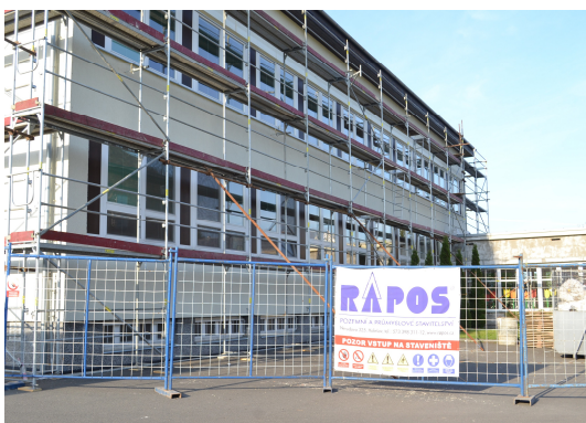
Zateplování budovy školy.
