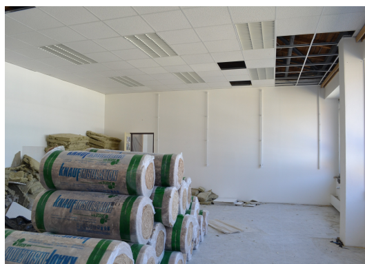
Rekonstrukce stropů v pavilonu B.
