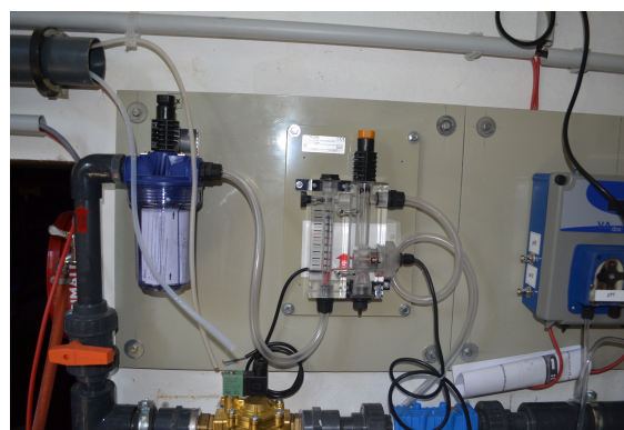
Chemické dávkování ve školním bazénu
